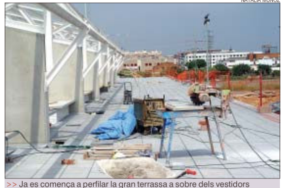
&gt;&gt; Ja es comença a perfilar la gran terrassa a sobre dels vestidors
